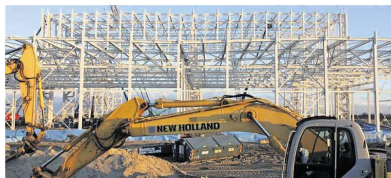
Sobald die Halle für das Siemenswerk steht, werden die Schweizer mit dem Einbau der komplexen Gebäudetechnik beginnen. Foto: Sassen
